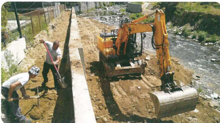
Основен ремонт на топлопровод за минерална вода от водоизточник, попадащ в ПИ с идентификатор 38844.101.95 по КК на гр. Костандово, общ. Ракитово, обл. Пазарджик
