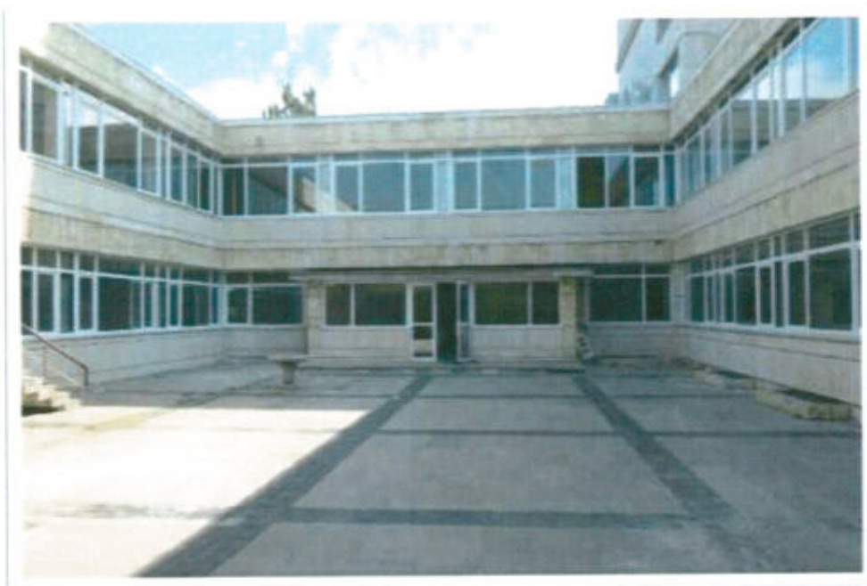
Проект 281 Изпълнение на мерки за енергийна ефективност в сградата на ДКЦ-1, гр. Червен бряг, обл. Плевен
