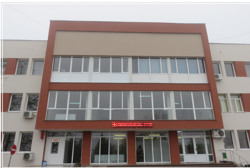
Проект 292 - „Повишаване на енергийната ефективност на сградата на „ Медицински център I - Първомай „ ЕООД, община Първомай“
