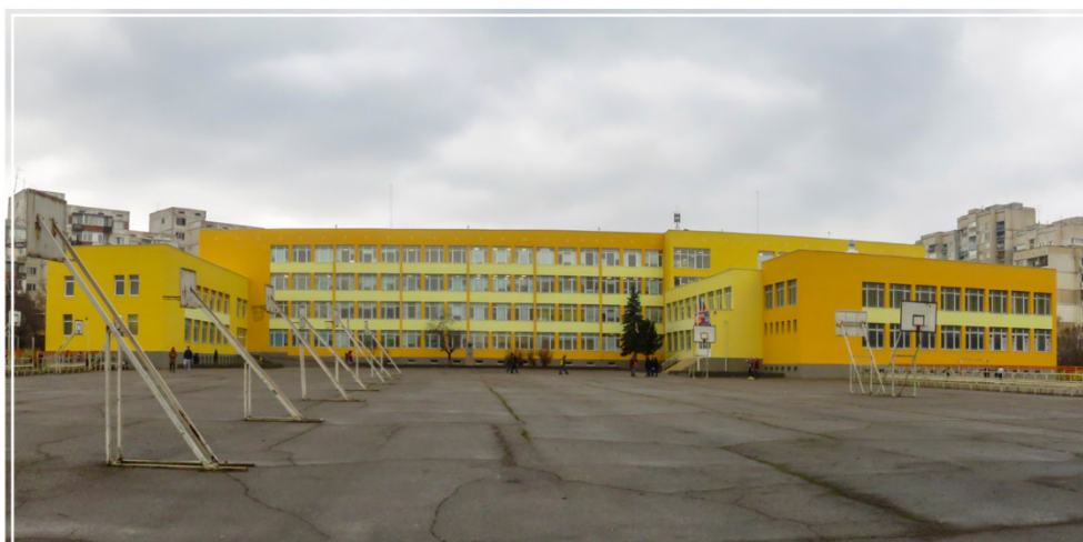
Проект № 502 - „Подобряване на енергийната ефективност на 79 СУ „Индира Ганди“ в УПИ XIII- за училище, кв. 4, м. „Люлин-7 м.р.“, по плана на гр. София, съгласно актуализиран Доклад за обследване на енергийна ефективност“
