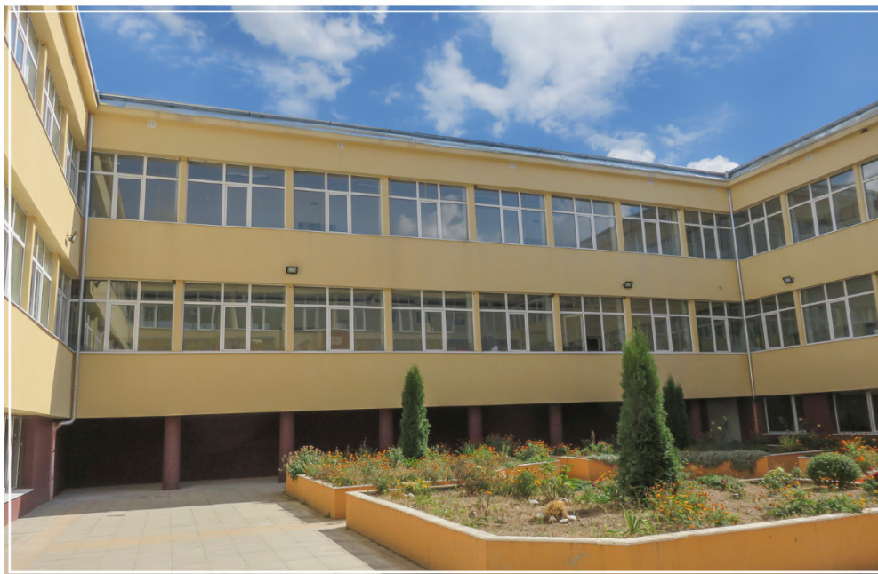
Проект 359 - "Подобряване на енергийната ефективност на сградата на 86 ОУ „Св. Климент Охридски“ - с. Владая, ул. „Брезова гора“ №2, район „Витоша“, Столична община“
