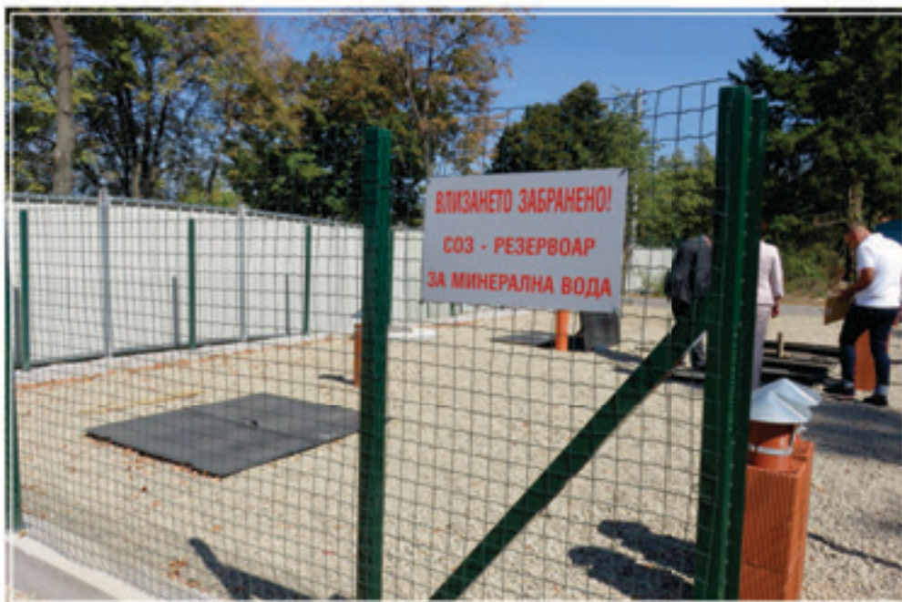
Проект МВ 003 -Подобряване и разширяване на ефективното използване на минералните води от находище „Сапарева баня“, обект: Направа на резервоар за минерална вода и довеждащ и отвеждащ водопровод.
