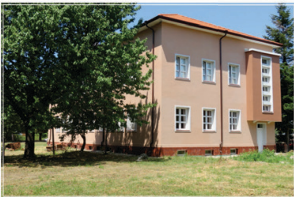
Проект 295 - Изпълнение на пакет мерки за повишаване на енергийна ефективност на сграда за комплексно обслужване в с. Селановци, ул. „Стефан Стамболов“ 51.
