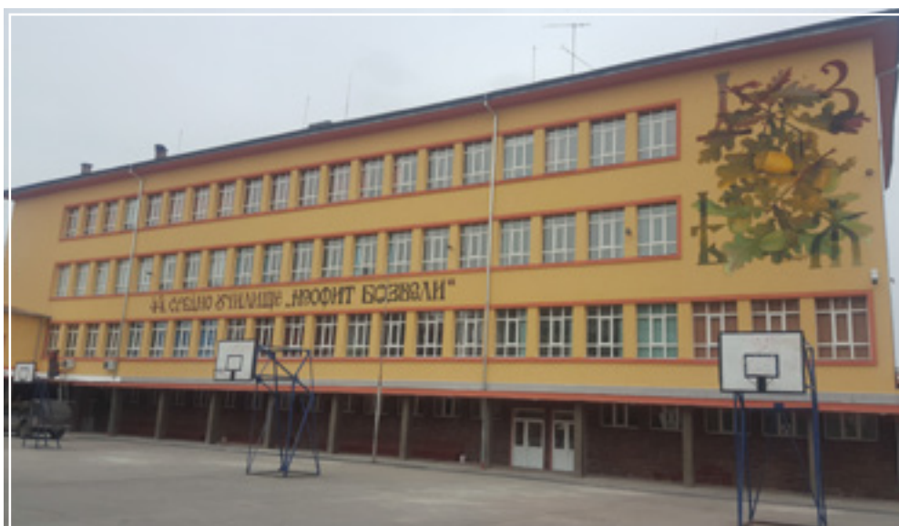
Проект № 329 „Повишаване на енергийната ефективност в 44-то СООУ „Неофит Бозвели“, район „Подуяне“, гр. София“
