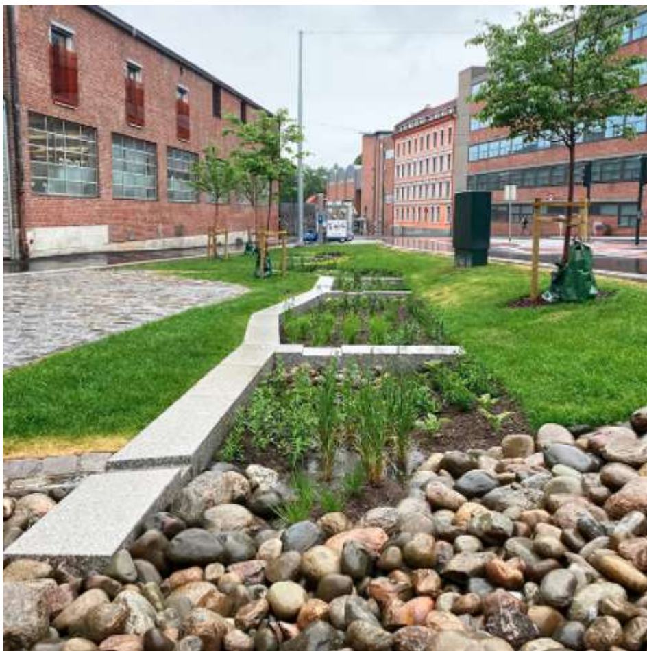
Фигура 17 Дъждовна градина, създадена върху преди това запечатана повърхност. Снимка: Таран Фергюс, Община Осло
